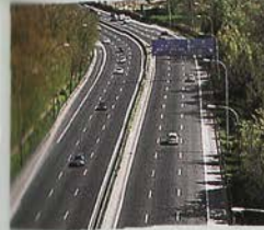
la autopista la autopista
