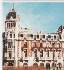
La oficina central está en Madrid. la ofiçina çentral está en madrid Головной офис находится в Мадриде.
